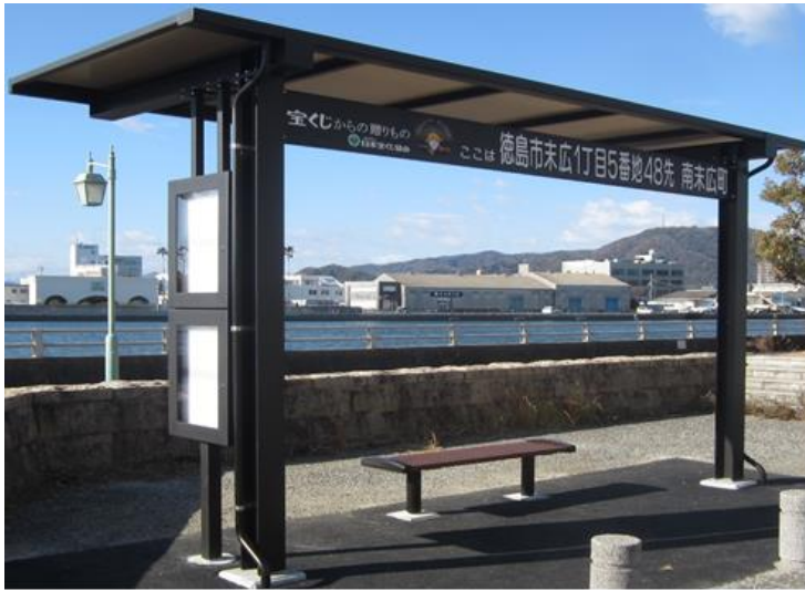
令和4年度に設置したバス停留所上屋 ≪案内板、ベンチ付き≫ 南末広町（徳島市）
