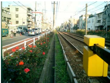
新設軌道敷内の緑化
