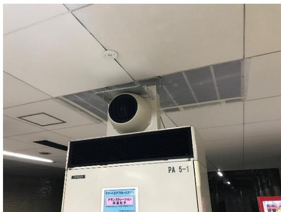
既存のエアコンの上に設置したスマートエアフローシステム（丸い形をしたものが吹き出し口であり、そこに、大風量の冷気と長い気流を生み出すルーバーがあります。）
